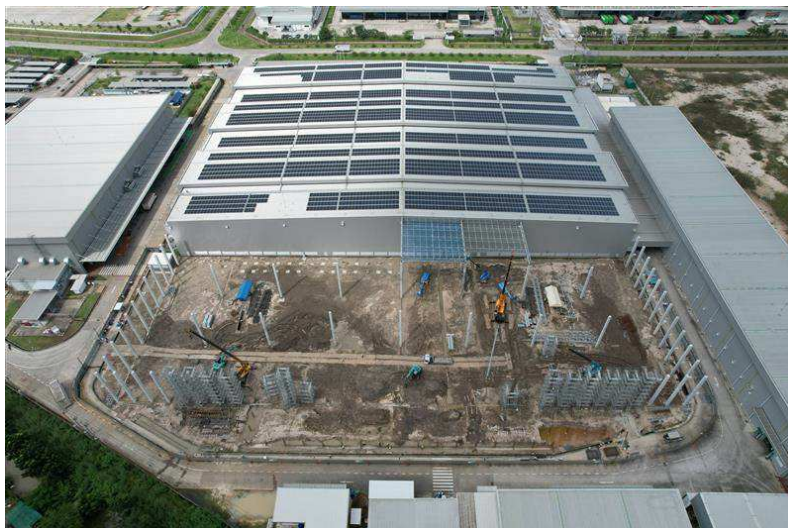
新工場建設の様子
